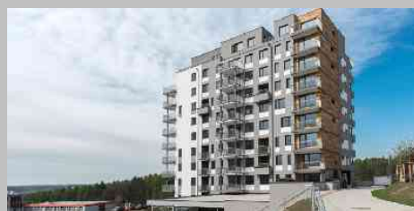
Byty Nad Pehradou_2
