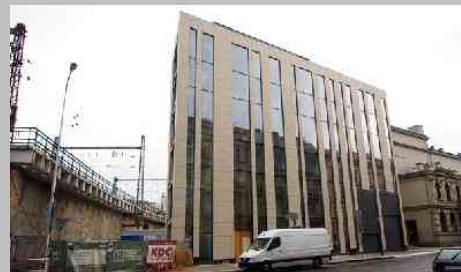
Admin. budova K71 Praha 2
