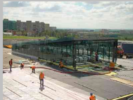
Stanice metra Střížkov
