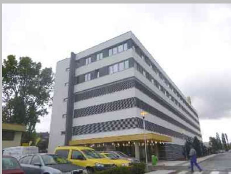
Polyfunkční objekt Praha 8_1
