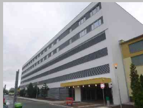
Polyfunkční objekt Praha 8_2
