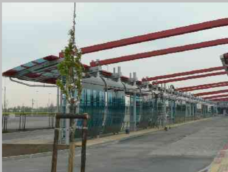
Stanice metra Letňany 2
