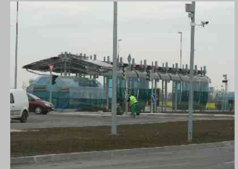
Stanice metra Letňany 1
