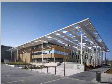
ELI Dolní Břežany_1
