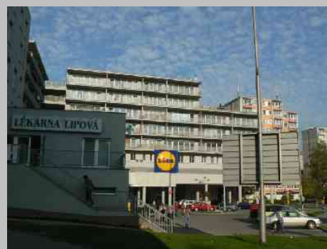
BYTOVÝ DŮM LIPOVÁ LB1
