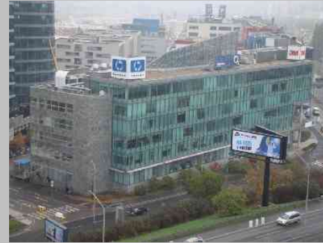
BB Centrum budova C
