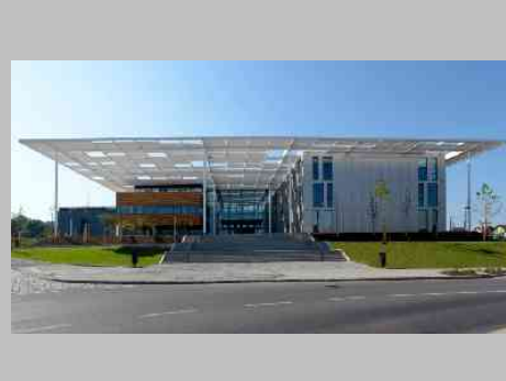
ELI Dolní Břežany_2
