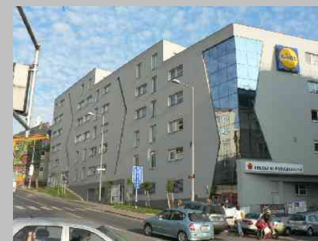
BYTOVÝ DŮM LIPOVÁ LB4
