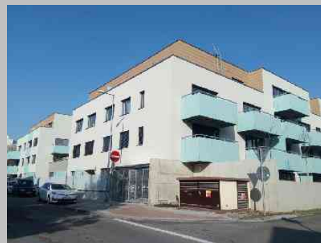
Byty V Zahrádkách Praha 10
