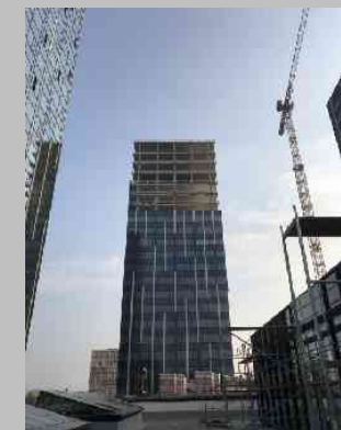
Komplex admin. budov Brno
